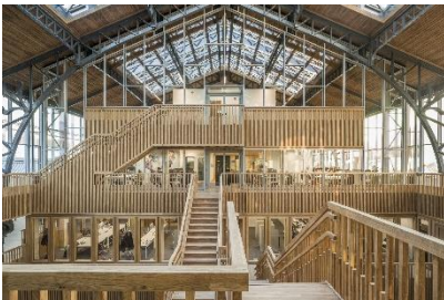
Gare Maritime i Bruxelles, hvor ZÜBLIN Timber har projekteret, fabrikeret og udført hele trækonstruktionen. Foto: Maxime Vermeulen
